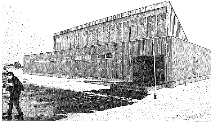
沼田工業団地に完成したハイテクインターの「北海道開発テストセンター」
